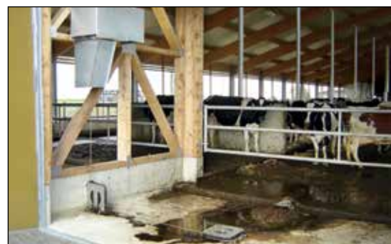
Montage Antriebswinde EW4 und Umlenkrollen
