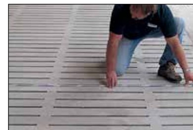
Spaltenboden wird vermessen
