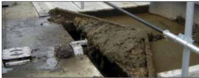
Faltschieber am Abwurf
