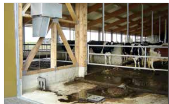
Montage Antriebswinde EW4 und Umlenkrollen
