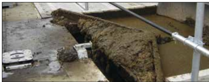
Faltschieber am Abwurf
