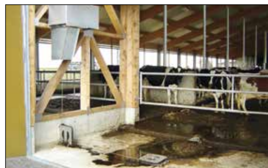
Montage Antriebswinde EW4 und Umlenkrollen
