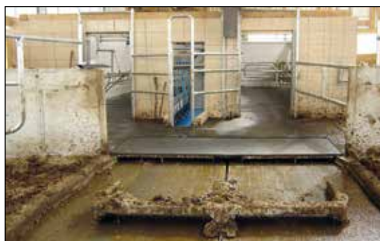
Klappbare Querkanalabdeckung vor dem Melkstand
