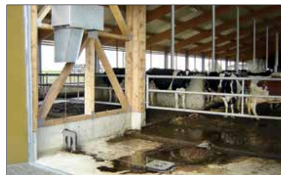
Montage Antriebswinde EW4 und Umlenkrollen
