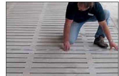
Spaltenboden wird vermessen
