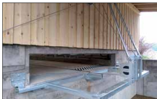
Klappbarer Ausleger für tieferliegende Dungelege
