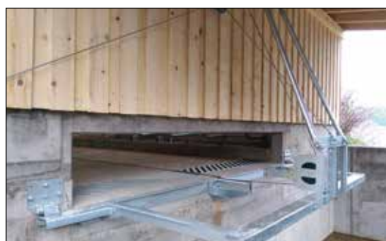
Klappbarer Ausleger für tieferliegende Dungelege
