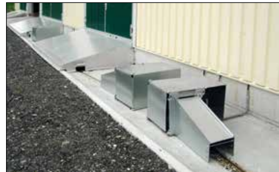
Antriebswinde EW4 und Querkanalabdeckung
