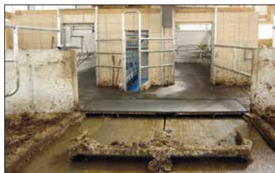
Klappbare Querkanalabdeckung vor dem Melkstand
